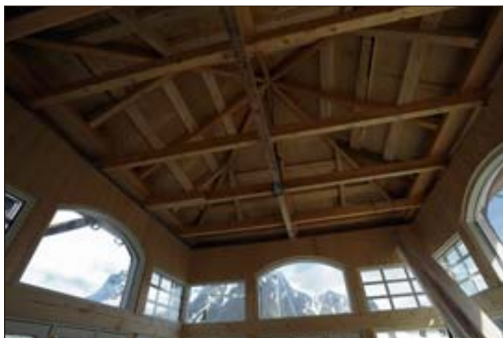
Fredag 4. mai ble taket løftet på, og det gjenstår å bordkle det innvendig, som man ser.
